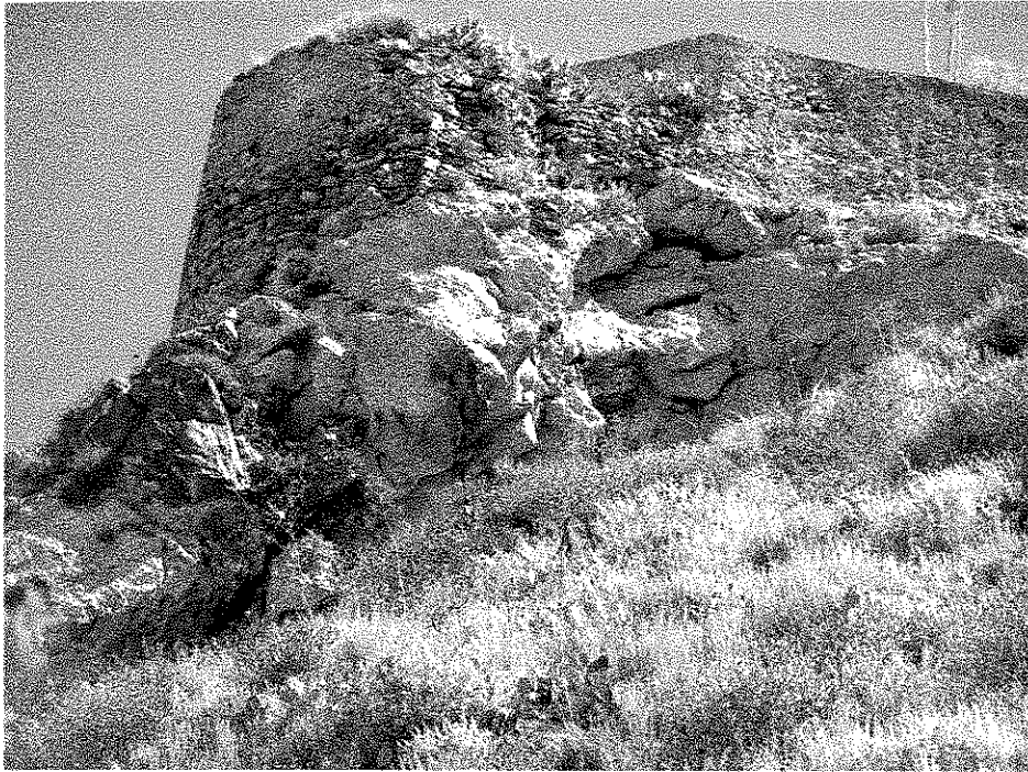
Foto n° 7, si evidenzia il grado di fratturazione delle rocce, che fanno da piede ai muri del castello, con rischio di crollo anche dei muri perimetrali del castello stesso.
