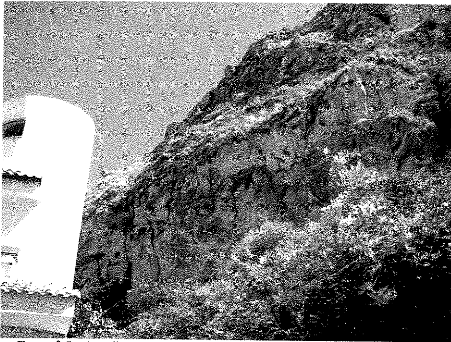
Foto n° 5, vista di parte del versante sotto il castello, e alle spalle delle abitazioni, con massi posti in equilibrio precario.
