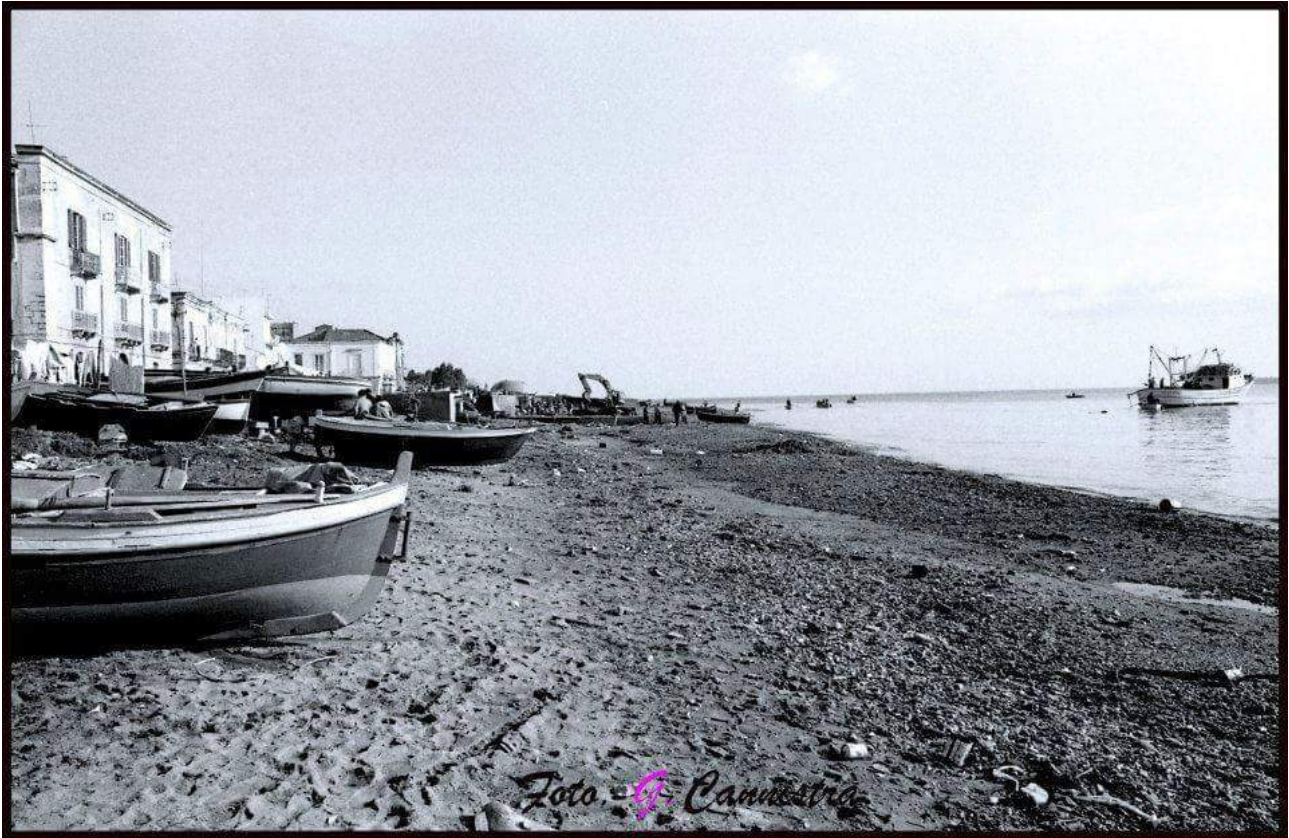
FOTO N. 1: Cunettone n. 4 (Vecchia foto storica)
